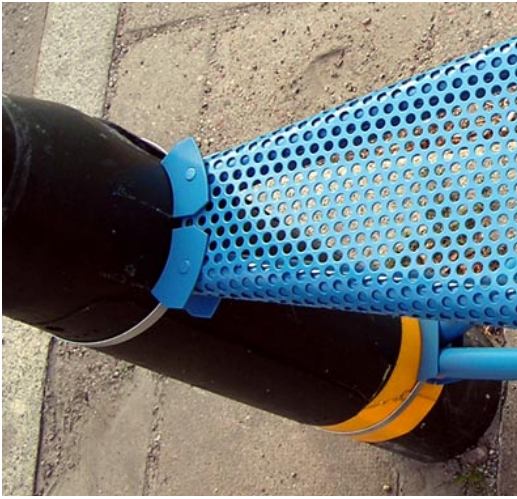
Bilden visar den typ av fästen jag bestämde mig för, med ett örörligt fast nedre fäste och två ledade övre fästen.
