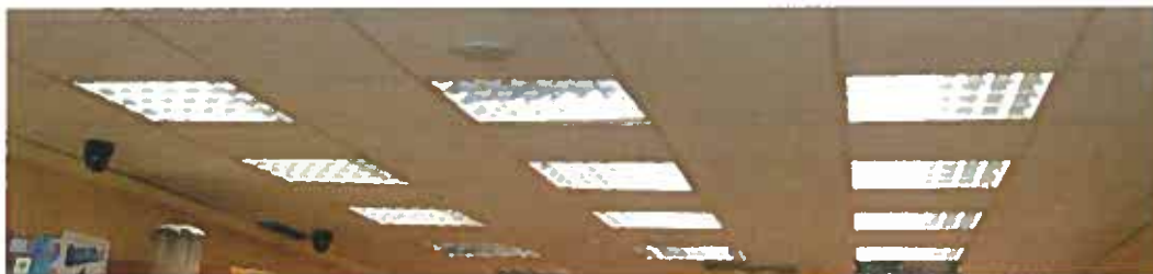
Kontorstak täckt av vitt ljudabsorberande plattsystem.
